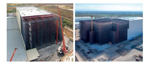
MAXIMUM CONSTRUCTION HEIGHT: CLAD-RACK WAREHOUSES CAN BE BUILT FROM AS LITTLE AS 12 M UP TO 45 M HIGH.
